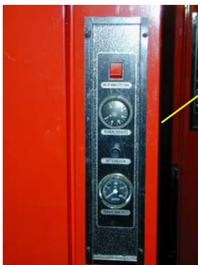
Figura 2: quadro di controllo della caldaia
